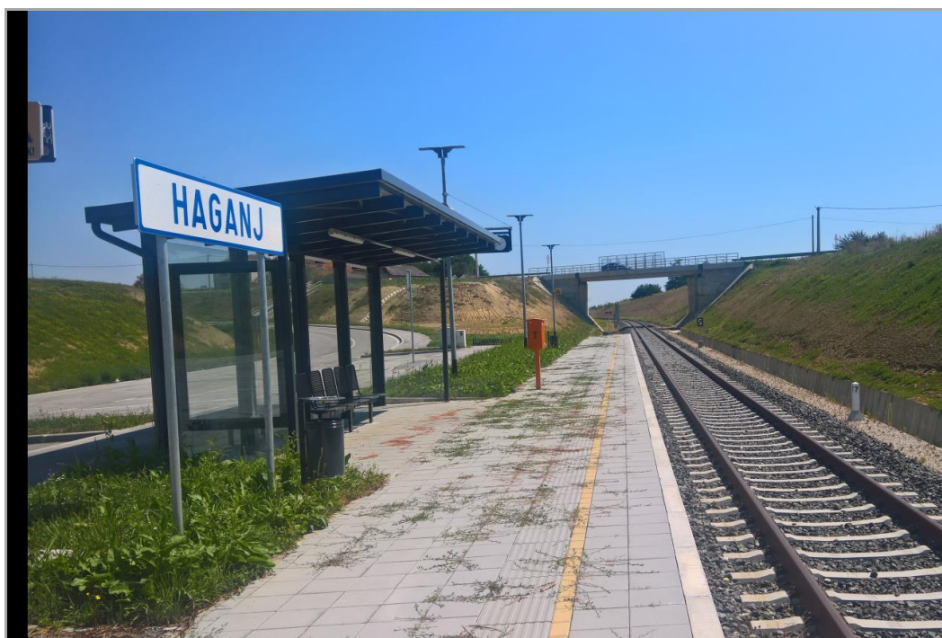
Slika 9. Novoizgrađena željeznička pruga L 214 -Gradec
